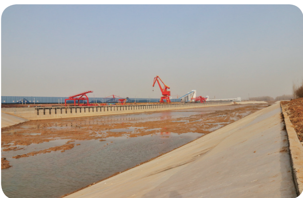
济宁港梁山港区寿张集作业区土建工程已进入全面收尾阶段。
